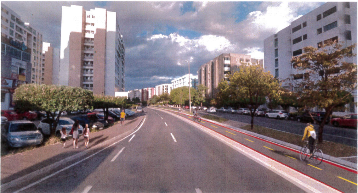
Figura 4 - Proposta com a supressão de uma faixa de rolamento e inserção de ciclovia bidirecional próxima ao canteiro. Fonte: COPROJ, 2018
