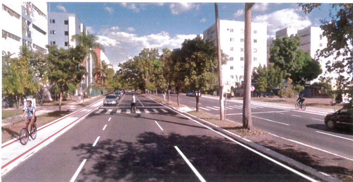
Figura 2 - Proposta com a supressão de uma faixa de rolamento e inserção de ciclovia unidirecional. Fonte: COPROJ, 2018
