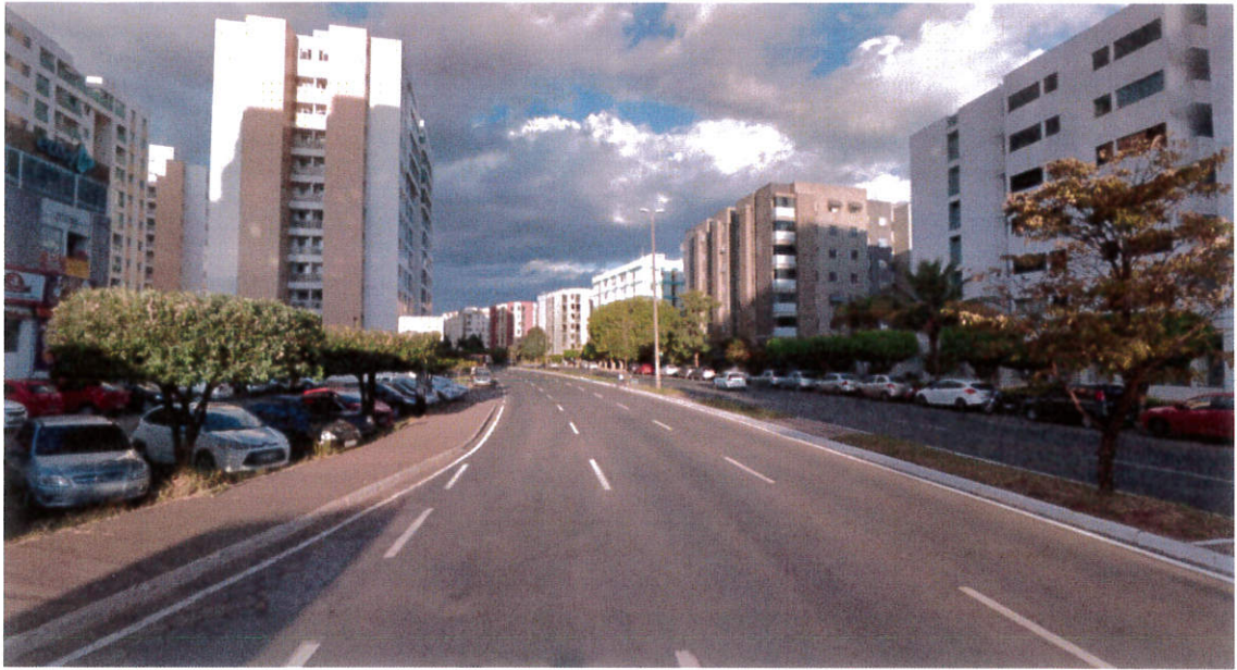
Figura 3 - Situação atual do trecho 2 com veículos estacionados ao longo da via. Fonte Google Street view, 2018.
